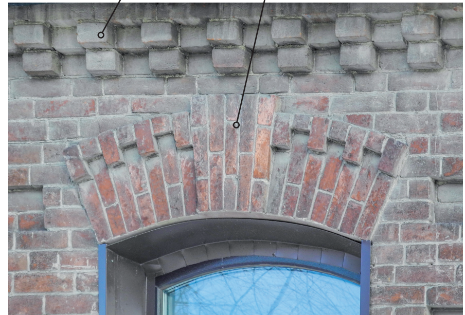
Перемычка над оконным проемом
